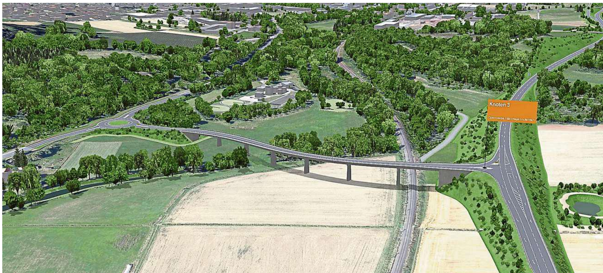
Viel diskutiert wurde der Knoten 3, der zwischen Angersbach und Lauterbach in Höhe der Ziegelei liegt. Im Bild zu sehen ist der Blick von Angersbach herkommend. Bei dem Teich rechts neben der neuen Bundesstraße handelt es sich um eines der zahlreichen Regenrückhaltebecken entlang der Strecke. Fotos: Kempf/Hessen Mobil
